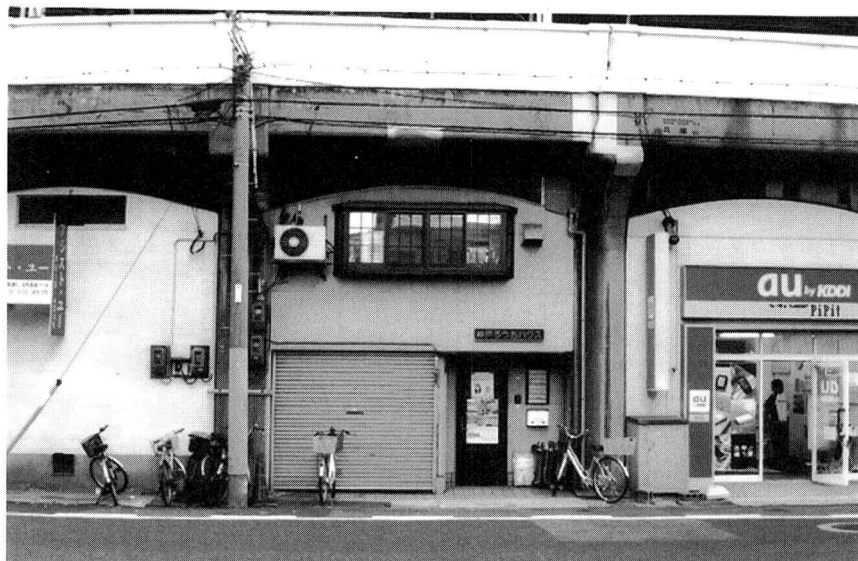
JR高架下にある「神戸ろうあハウス」
